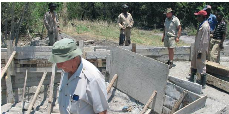
Abb. 5: Damm- und Einlaufbauwerk-Konstruktion mit den Stahlbeton-Eisenbahnschwellen, um die Erosion zu stoppen. Im Vordergrund Ted Reilly. Dam reinforcement and breaker and spillway construction with disused concrete-steel railway sleepers to stop erosion. In the foreground Ted Reilly.
