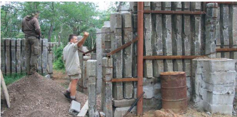
Abb. 6: Besichtigung der Boma für Nashörner, die weitestgehend aus ausgemusterten Stahlbeton-Eisenbahnschwellen gebaut wurde. Visit to the rhino boma, which was largely constructed from disused concrete-steel railway sleepers.
