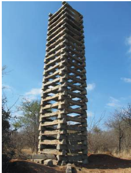
Abb. 7: Ein hoher aus Eisenbahnschwellen aufgeschichteter Wachturm. A tall watchtower, constructed from railway sleepers.
